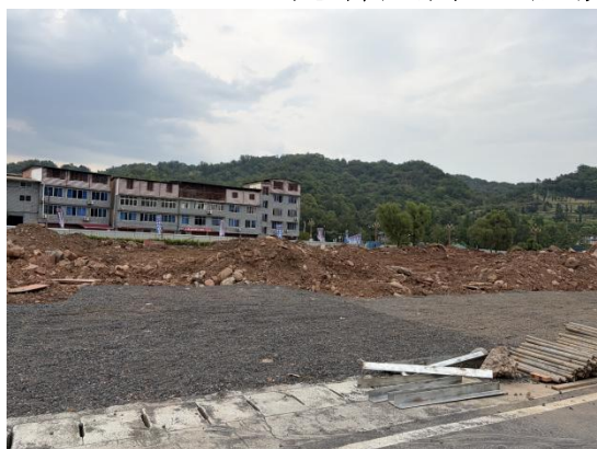
场地施工现状
