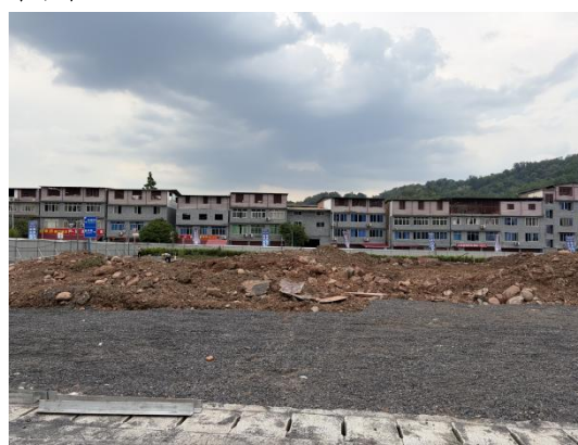
场地施工现状
