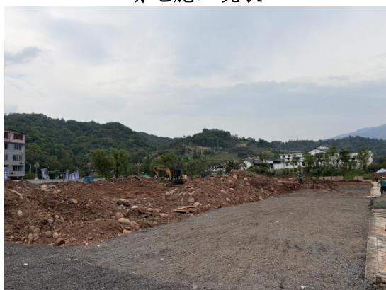
场地施工现状
