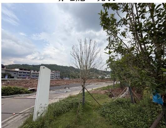
场地施工现状
