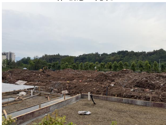
场地施工现状
