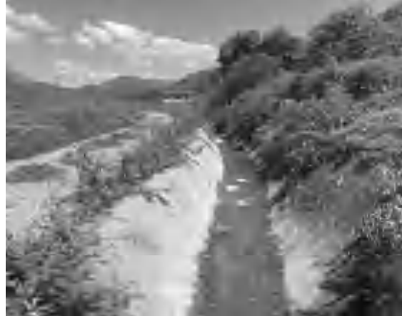
图 6 原三水厂地块靠山侧排洪沟
